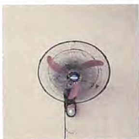
Foto 5: REPARACIÓN DE SISTEMA ELÉCTRICO sustitución de sistemas de ventilación: ventiladores. Aulas, cocina y corredor
