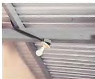
Foto 6: REPARACIÓN DE SISTEMA ELÉCTRICO sustitución de sistemas de iluminación: Lámparas
