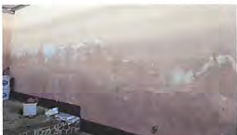
Foto 1: REPARACIÓN DE REPELLO Y CERNIDO DE PAREDES Reparación de repello y cernido en muro de mampostería con aplicación de acabado uniforme e impermeabilización, En corredor y fachada exterior
