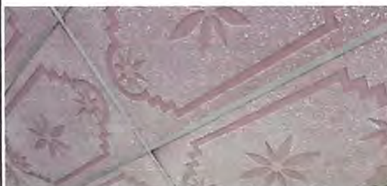
Foto 2: ESTRUCTURA DE CIELO FALSO Sustitución de estructura de cielo falso en aulas, cocina, bodega y corredor
