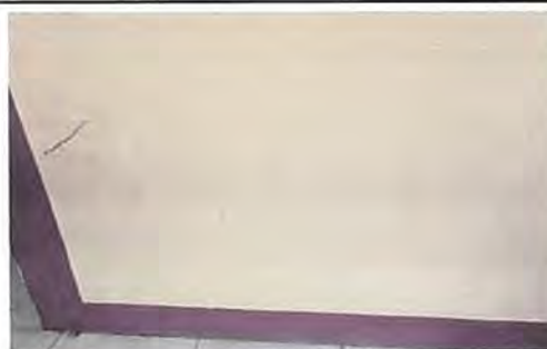
Foto 4: PINTURA EN MUROS INTERIOR Y EXTERIOR Preparación de la superficie y aplicación de pintura a dos manos, en paredes interiores y exteriores del establecimiento.
