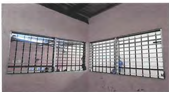
Foto 3: VENTANAS Sustitución de ventanas; sistema de apertura: Corredizas, Perfiles color blanco estándar, Material del marco: PVC Material de la ventana: Vidrio, sellado perimetral. Aulas, cocina y bodega
